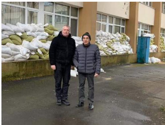
Sandsäcke zum Schutz der Fensterfronten im Stadtsptial Rivne
